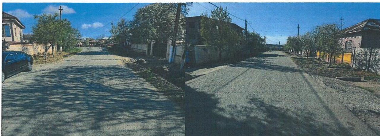
Șanțuri de pământ neprofilate, acostamente prăbușite, accese realizate in diferite variante de localnici
